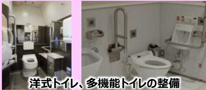
洋式トイレ、多機能トイレの整備
