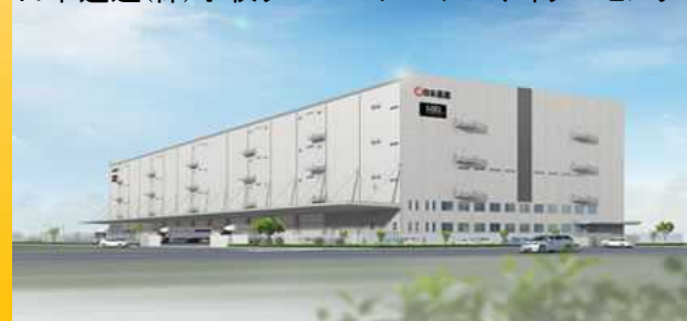
日本通運(株)小牧グローバルロジスティクスセンター
