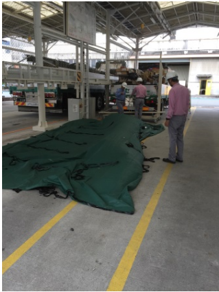
養生シート準備
