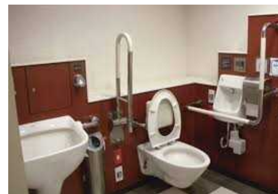
(障害者用トイレ)
