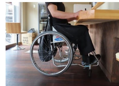
ローカウンターの設置
