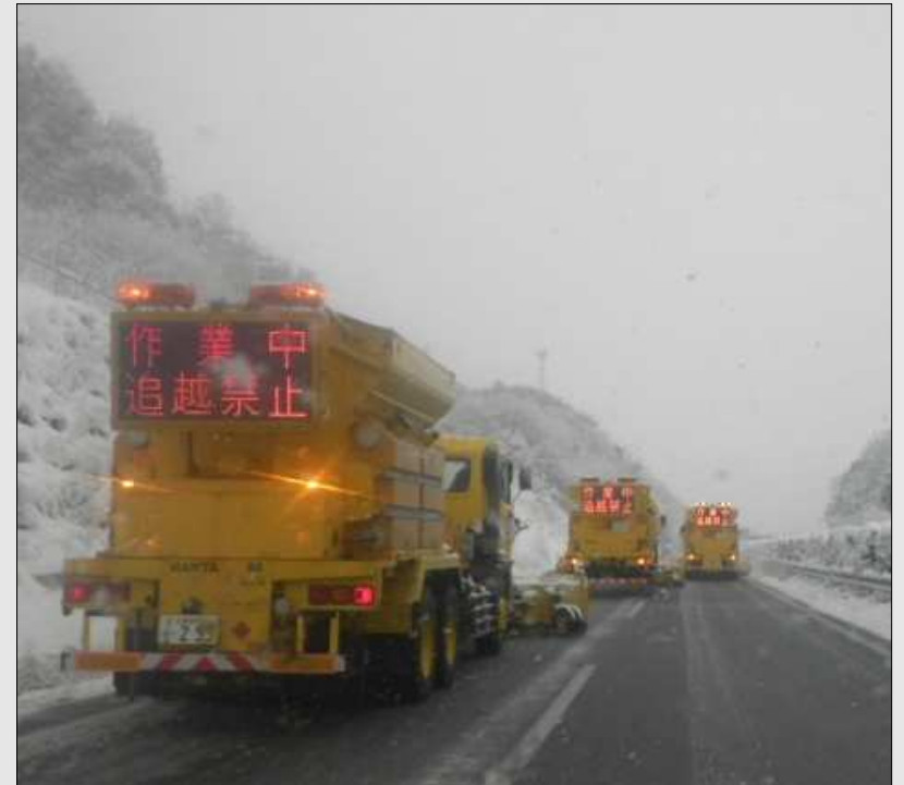
凍結防止剤散布作業
