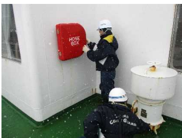
消火設備を点検する合同点検班
