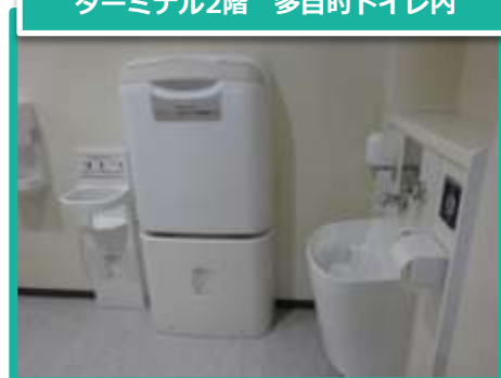
ターミナル2階 多目的トイレ内
