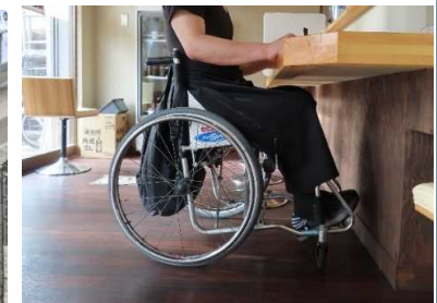
ローカウンターの設置
