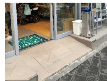
スロープの設置
