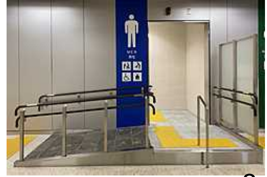
⑧通路側にスロープがせり出している例（写真はさっぽろ駅のもの）
