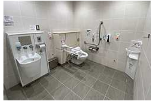
④一般トイレ内車椅子使用者用簡易型便房（オストメイト対応）
