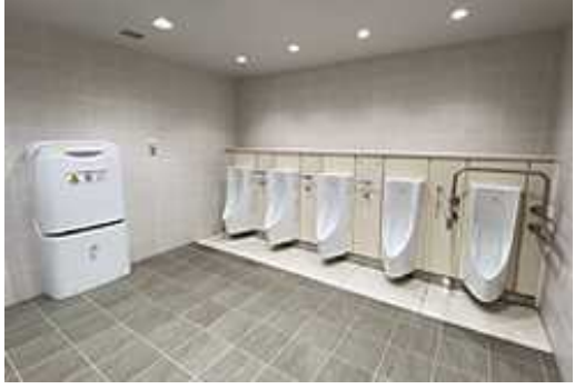
⑤男性トイレ内の小便器とおむつ交換台
