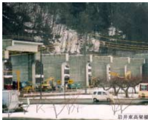
整備が進む北陸新幹線（長野県中野市） 資料：長野県土木部監理課
