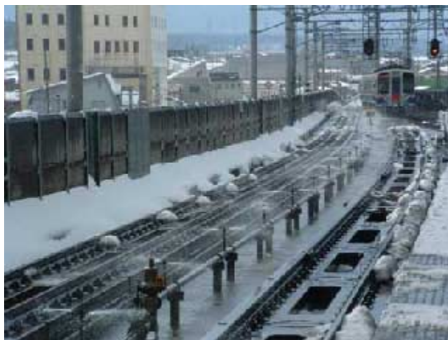
鉄道の雪対策の例（ほくほく線十日町駅構内） 資料：北越急行
