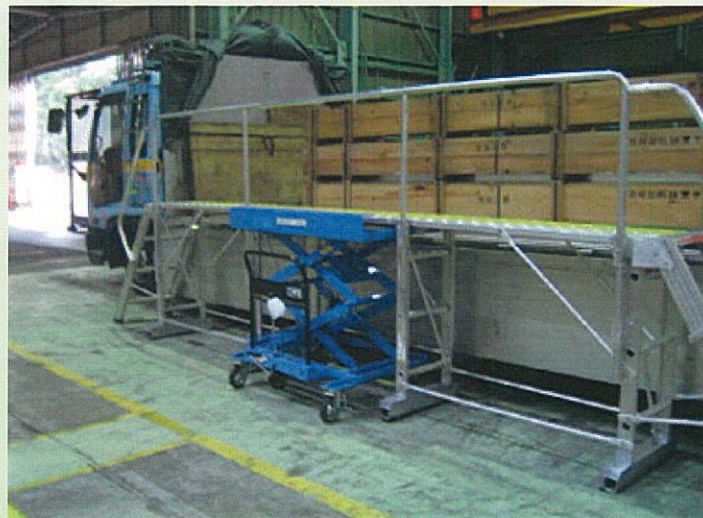
荷台への昇降設備の例 (陸上貨物運送事業者側で用意する場合であつても、荷主先等で保管場所の確保が必要)
