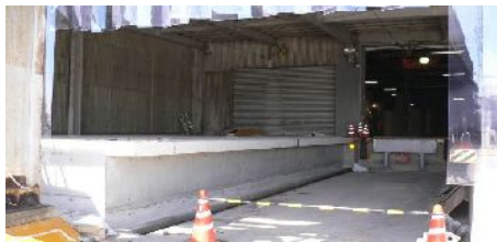
荷役ホーム拡張部分(工事中)
