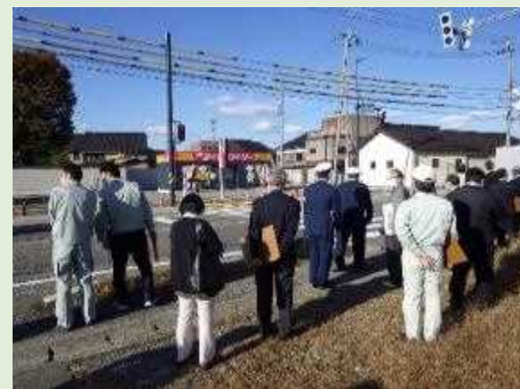
【整備中の国道8号の点検】
