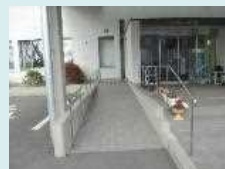
出入口の段差解消 事業費：30万円程度
