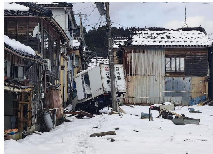
津波被害(珠洲市飯田町)
