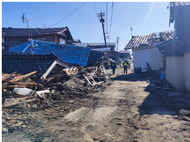
家屋倒壊+液状化+津波(珠洲市宝立町)
