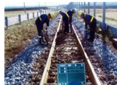
レールの修繕
