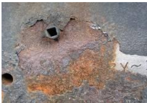
腐食し識別困難となった車台番号
