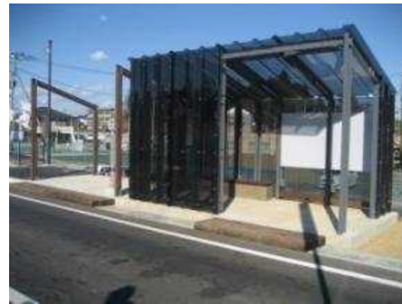
完成したバスシェルター（待合所）
