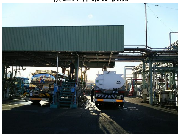
積込み作業の状況
