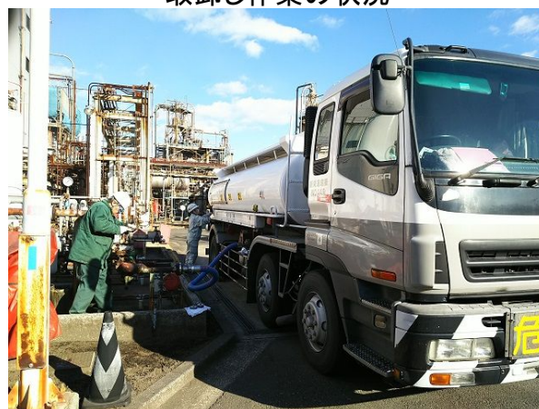
取卸し作業の状況
