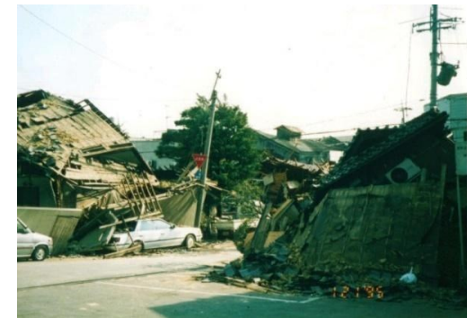
阪神・淡路大震災による被害状況
