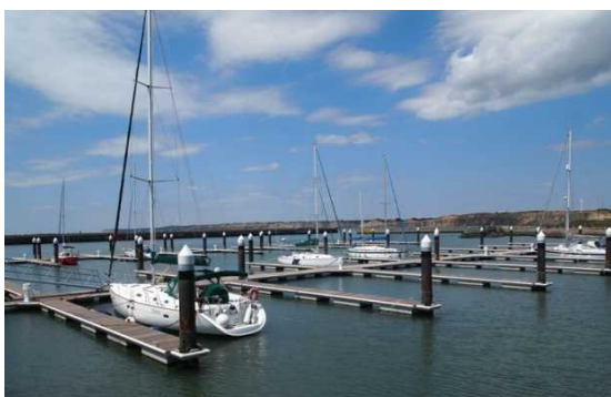
東日本大震災で被災。復旧工事を終え平成25年4月1日から再スタートした「ちょうし海の駅」。地元自治体の強力な支援があった。
