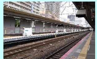
④整備された新型ホームドア
