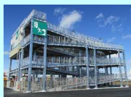
②津波避難タワーの外観
