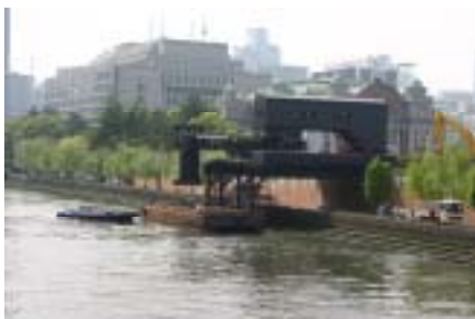
土砂積み出し桟橋(土佐堀川)
