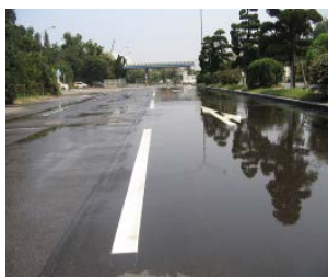
(構内道路自動散水)
