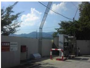
（自家給油設備）
