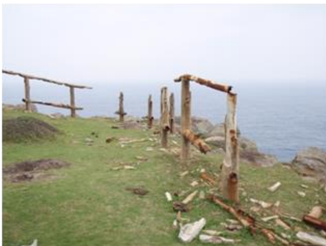
（老朽化した落下防止柵の再整備）
