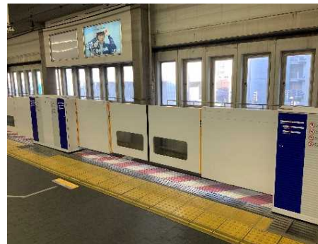
ホームドアの設置
