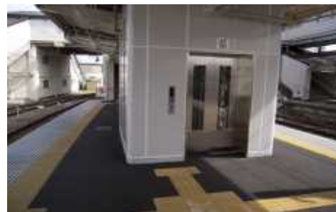
エレベーターの設置
