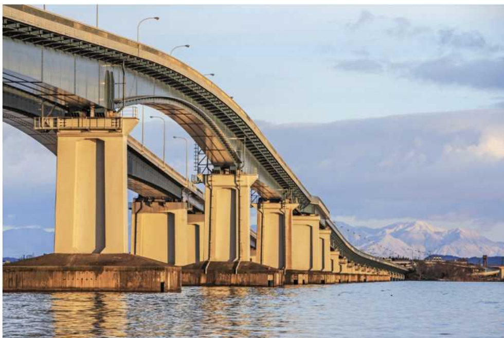
Pont Biwako (Préfecture de Shiga)
