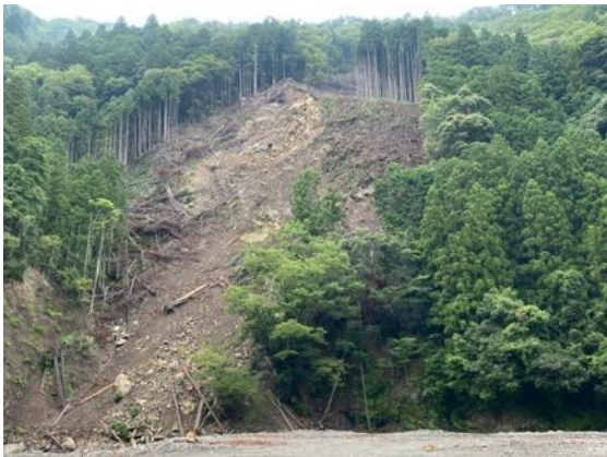
川津高野線733号の崩落箇所1
