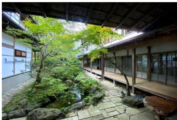
中庭と改装中の部屋の外観
