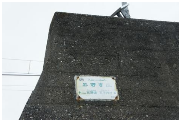
高所に設置された案内看板
