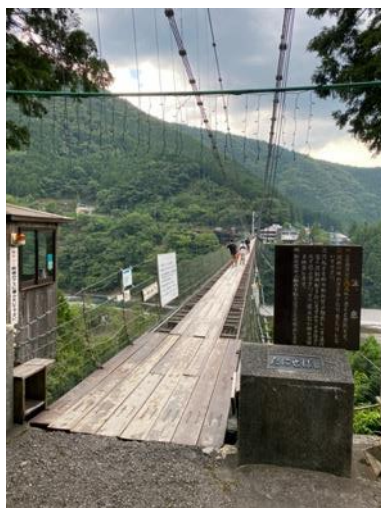
谷瀬の吊り橋2
