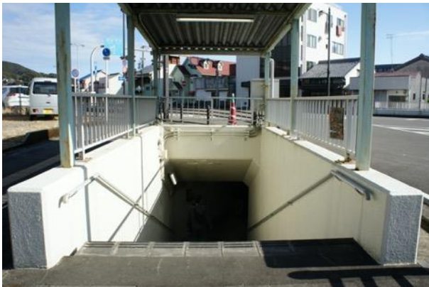
交差点 (地下道) : 参道側
