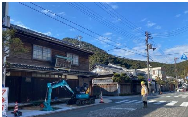
景観整備の様子
