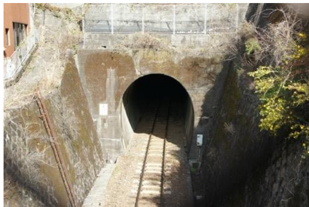
新宮城址の下を走るトンネル
