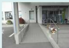
出入口の段差解消 事業費：30万円程度
