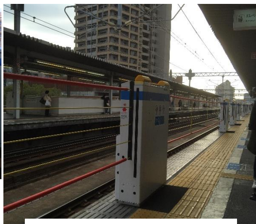
昇降ロープ式ホーム柵
