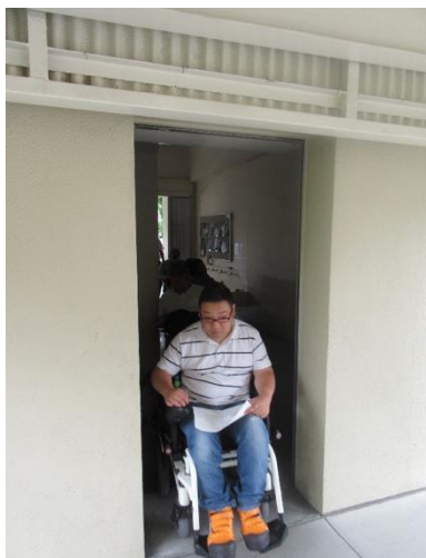
耐震補強して狭くなった通路
