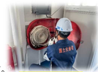
消火設備点検の様子
