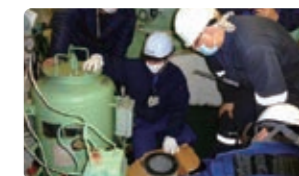
機関室の油水分離器の検査
