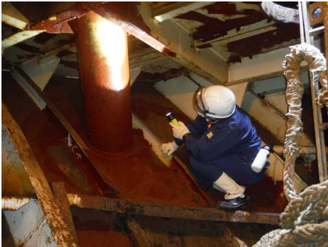
錨鎖孔(ホースパイプ)の検査
