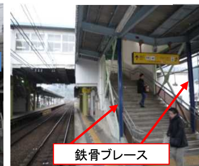
【橋上駅の補強】
