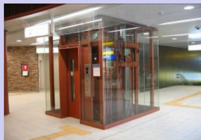
エレベーター
