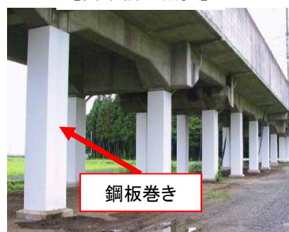
【高架橋の補強】
