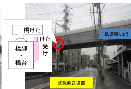
【橋りょうの補強】
