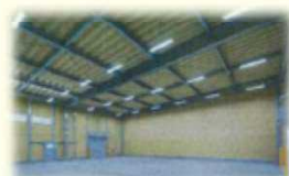
大規模流通に対応した保管施設
