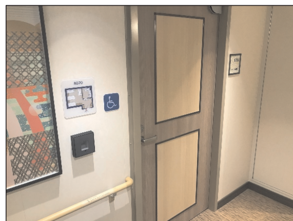
スイートバリアフリールームの 二次元バーコード自動開閉ドア
