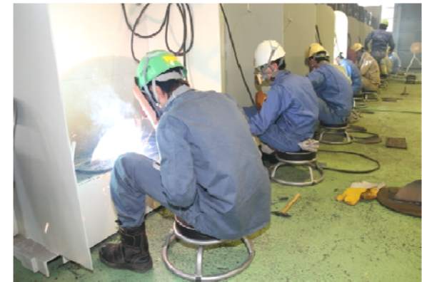
写真：研修における溶接作業風景
