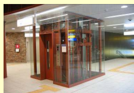
エレベーター
