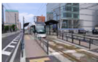
LRT(導入空間、センターホール、電停等)の整備
