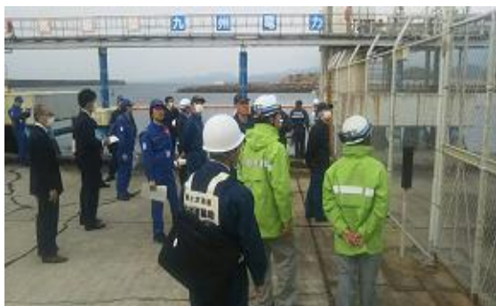
フェンスの設置状況を確認
