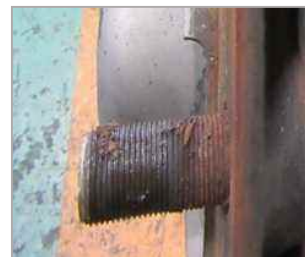
ボルトに著しいさびや汚れの付着
