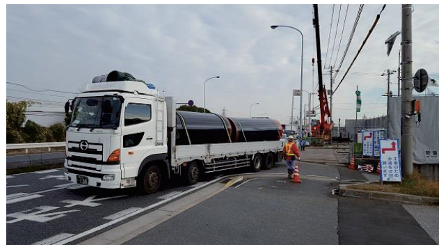
工事現場への納入時の状況
