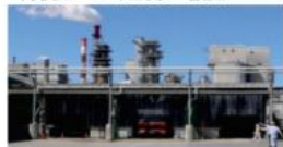
荷役ホーム（左側に増設）
