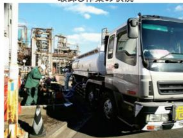
取卸し作業の状況
