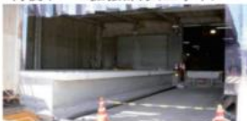
荷役ホーム拡張部分（工事中）
