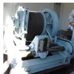
新設した上架設備
