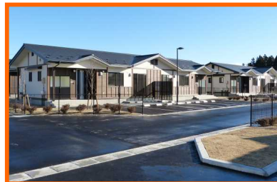
整備が完了した災害公営住宅
