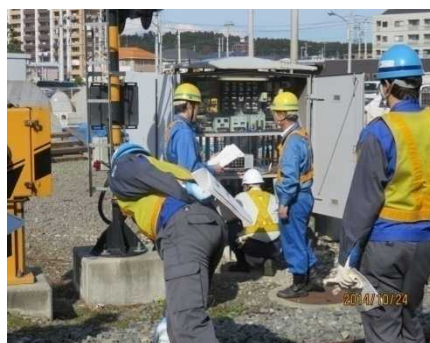
写真）踏切設備保守作業実習
