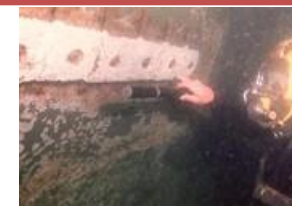
構造体の腐食防止措置の検査
