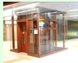
エレベーター
