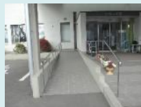
出入口の段差解消 事業費：30万円程度
