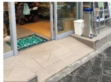
スロープの設置
