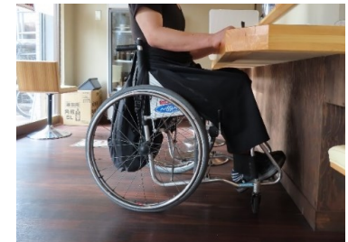
ローカウンターの設置
