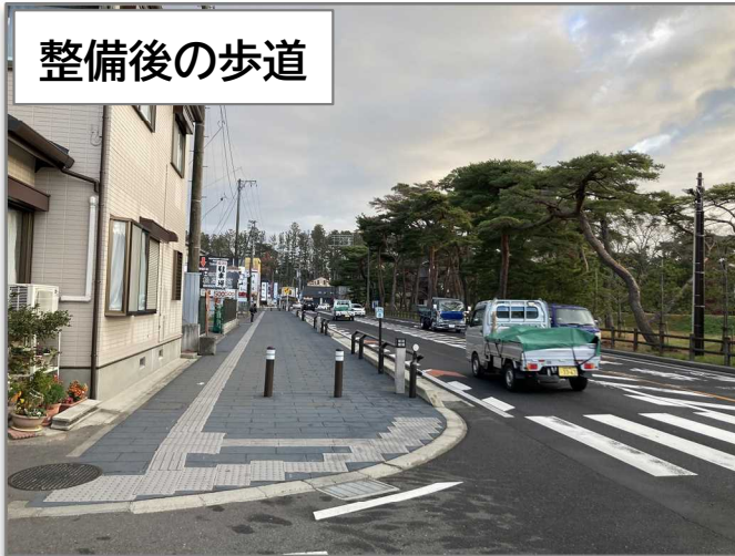
整備後の歩道
