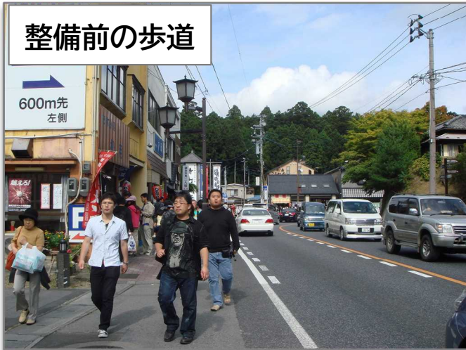
整備前の歩道
